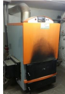
3. ábra. A bükk-szentkereszti iskola aprítéktüzelésű kazánja Fotó: Szépvölgyi Gergő
